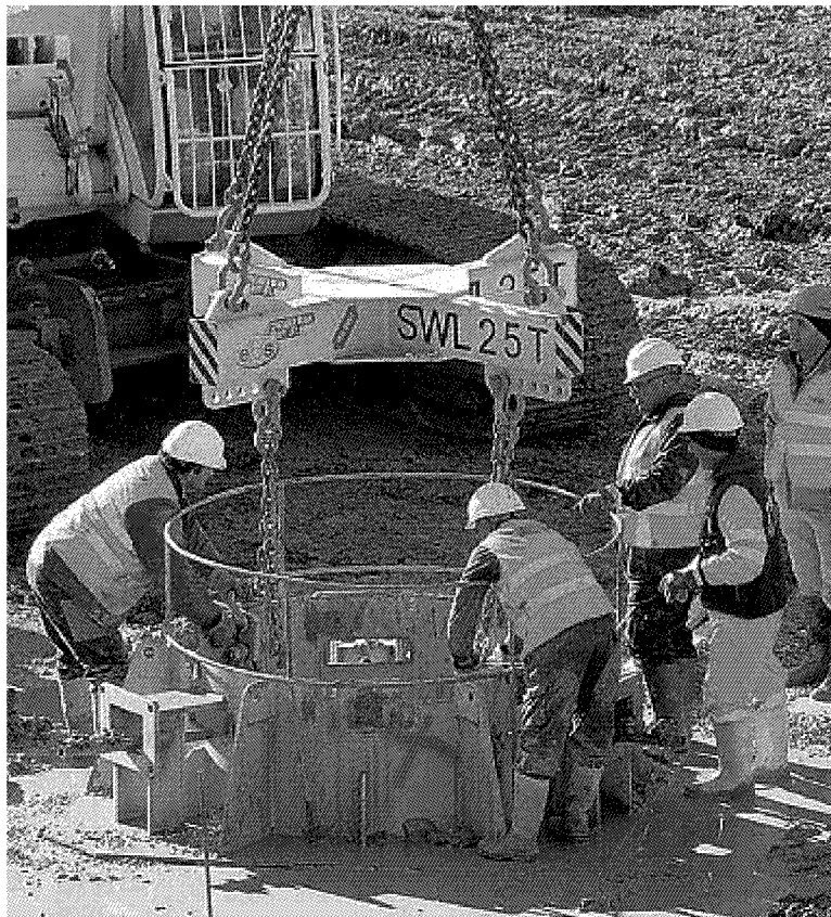
Operai al lavoro sul cantiere dell'Alta velocità ferroviaria
