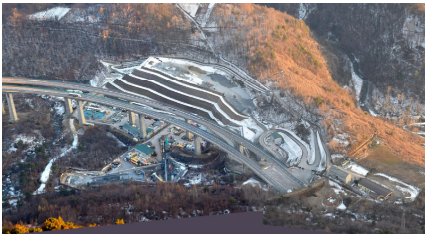
Fig. 1 - Il cantiere di Chiomonte (foto Diego Fulcheri)
