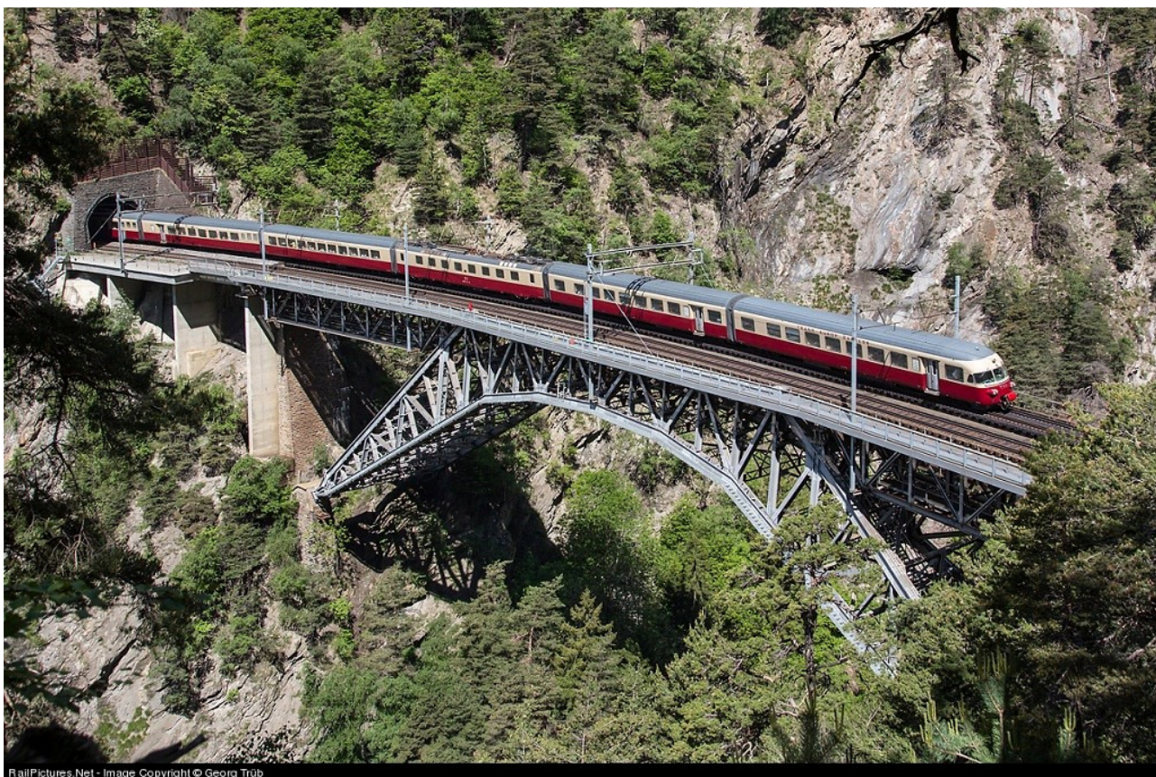
La Bietschtalbrücke è uno spettacolare ponte ferroviario metallico sulla linea del Lötschberg in Svizzera
