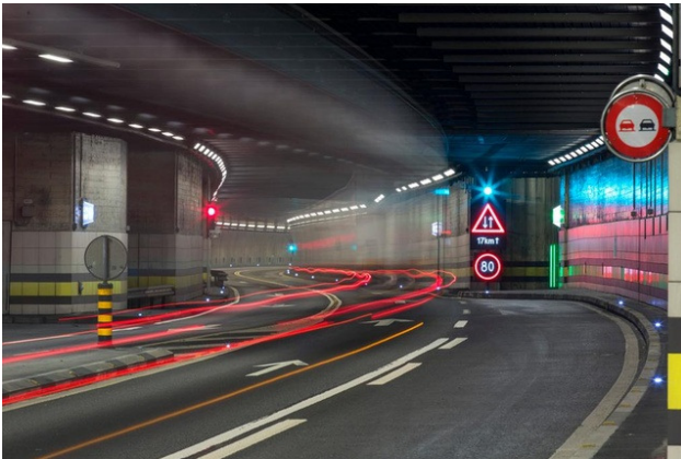
Il traforo autostradale del Gottardo inaugurato il 5 settembre 1980
