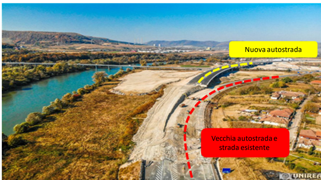
Figura 6 – Collegamento delle tratte Lugoj-Deva e Deva-Orăștie dell'autostrada A1 in Romania
