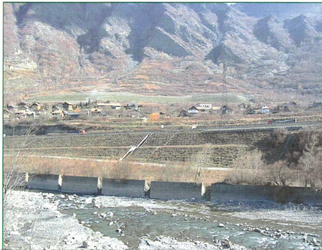
Dispositif de mur, crénelé au droit de Sous-Villard-Clement.
