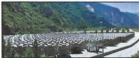
Figura 37 – Stoccaggio dei conci prefabbricati per il cantiere della Galleria di Sicurezza del Frejus (presso St. Etienne de Cuines, Francia) – Movimentazione con carro-ponte su rotaia o su gomma.
