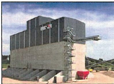
Figura 38 – Impianto di valorizzazione dei materiali di scavo – Particolare della tipologia di schermatura contro rumore e polveri
