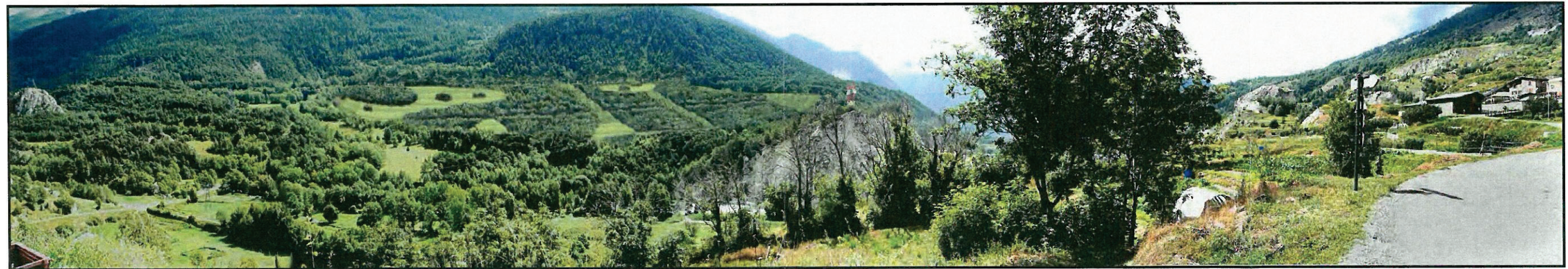
Figure 18 : Phase 5 des travaux de mise en dépôt
