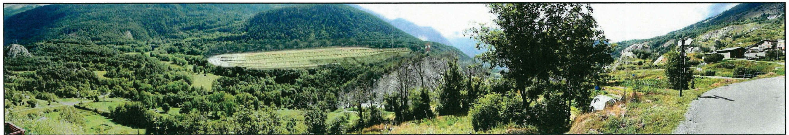
Figure 16 : Phase 3 des travaux de mise en dépôt
