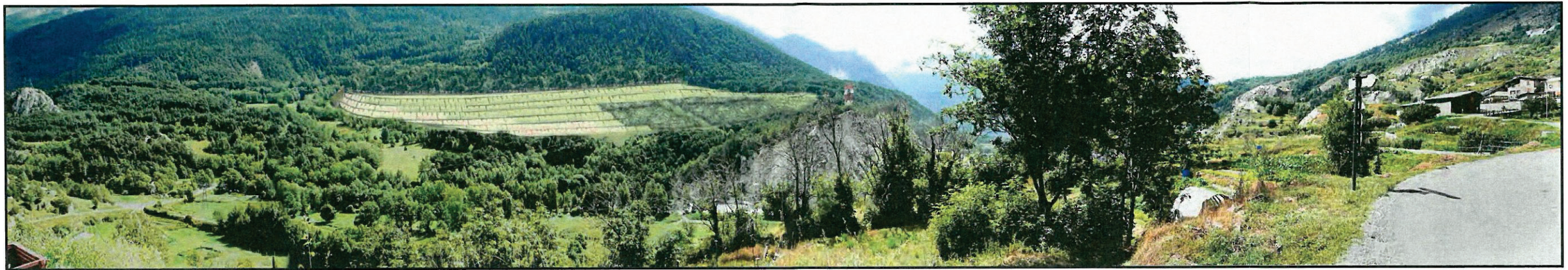
Figure 17 : Phase 4 des travaux de mise en dépôt
