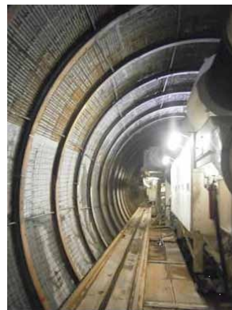
La Maddalena Soutènement de la galerie par cintres et treillis
