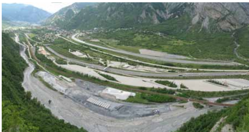
Saint-Julien-Montdenis Site de dépôt d'Ilaz
