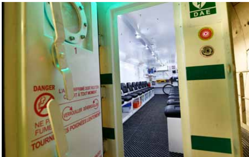
Saint-Martin-la-Porte Cabine de survie
