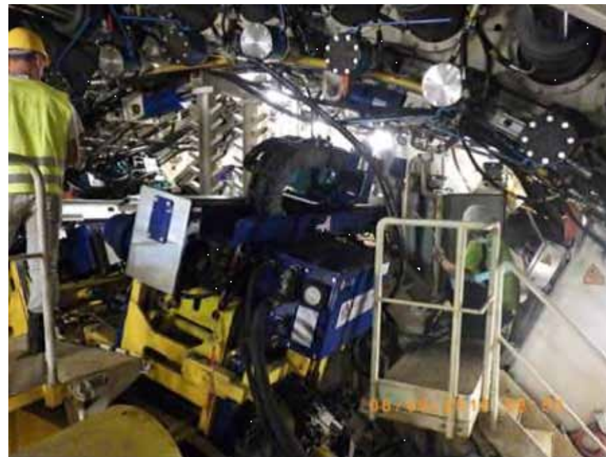
Saint-Martin-la-Porte Montage tunnelier : Foreuse
