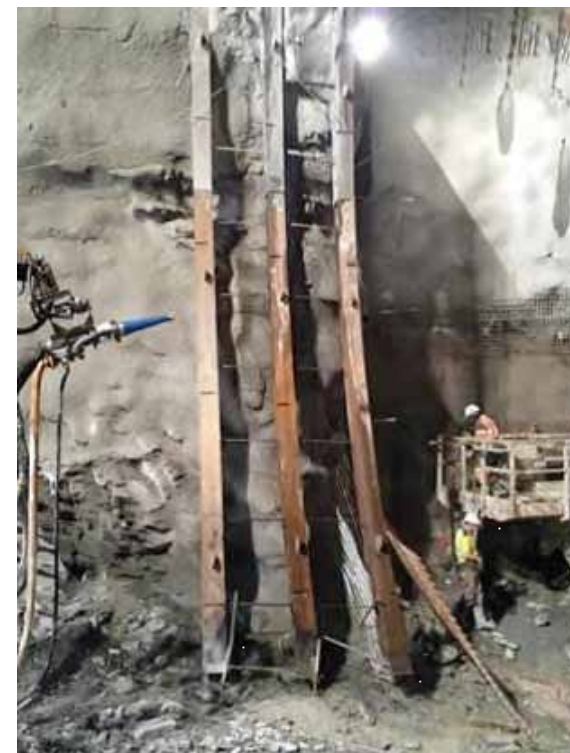
Saint-Martin-la-Porte Rampe d'accès : Pose cintres HEB et bétonnage de remplissage de cintres
