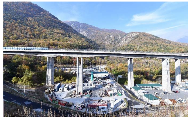
Chiomonte plateforme de chantier / piattaforma del cantiere
