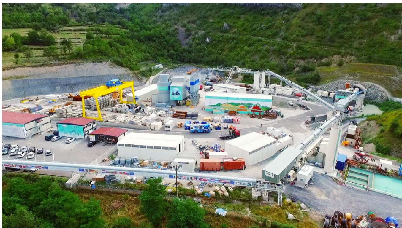
Chantier / cantiere Saint-Martin-La-Porte
