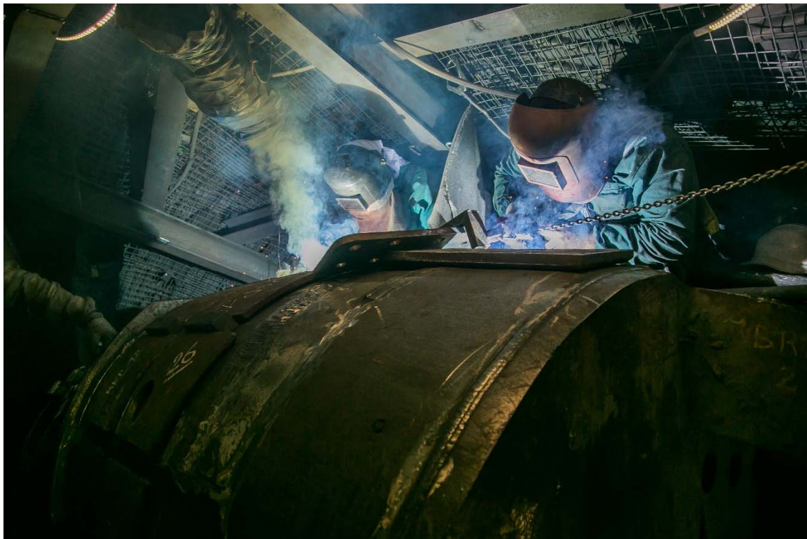
Saint-Martin-La-Porte Maintenance du tunnelier / Manutenzione della fresa
