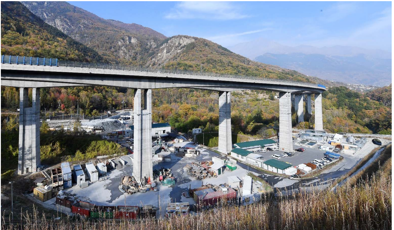
Chantier / Cantiere Chiomonte
