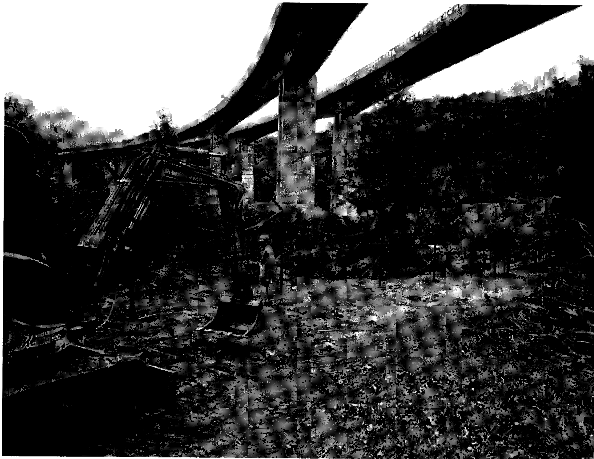
LTF - Travaux de préparation du chantier de La Maddalena
