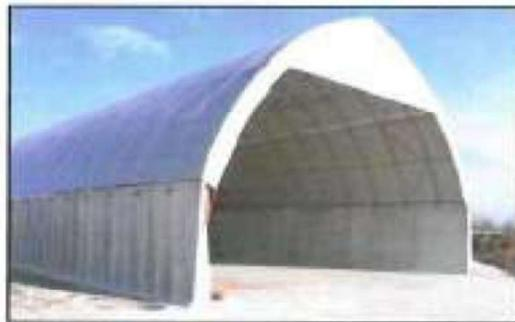
*Figura 76 – Silos orizzontale con copertura tipo "tenso-struttura"*
