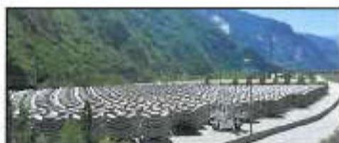
*Figura 37 – Stoccaggio dei conci prefabbricati per il cantiere della Galleria di Sicurezza del Frefjus (presso St. Etienne de Cuines, Francia) – Movimentazione con carro-ponte su gomma*
