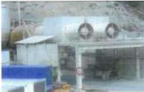
*Figura 40 – Impianto di ventilazione – Particolare dei silenziatori e carter di insonorizzazione dei motori*
